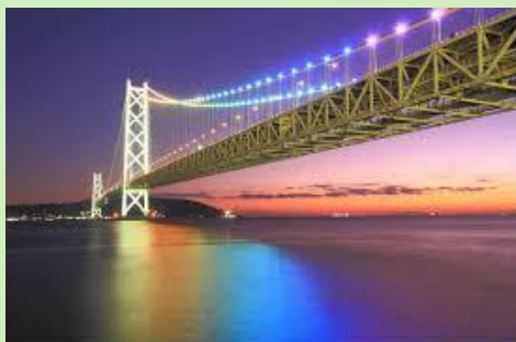
明石海峡大橋
